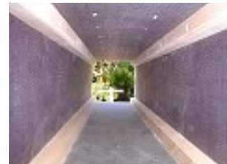
▲ Durchblick durch den Stauraum
